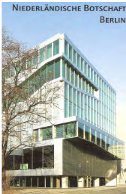
An der Fassade außen rechts und in der Fensterfront an zwei Seiten erkennt man das Trajekt
