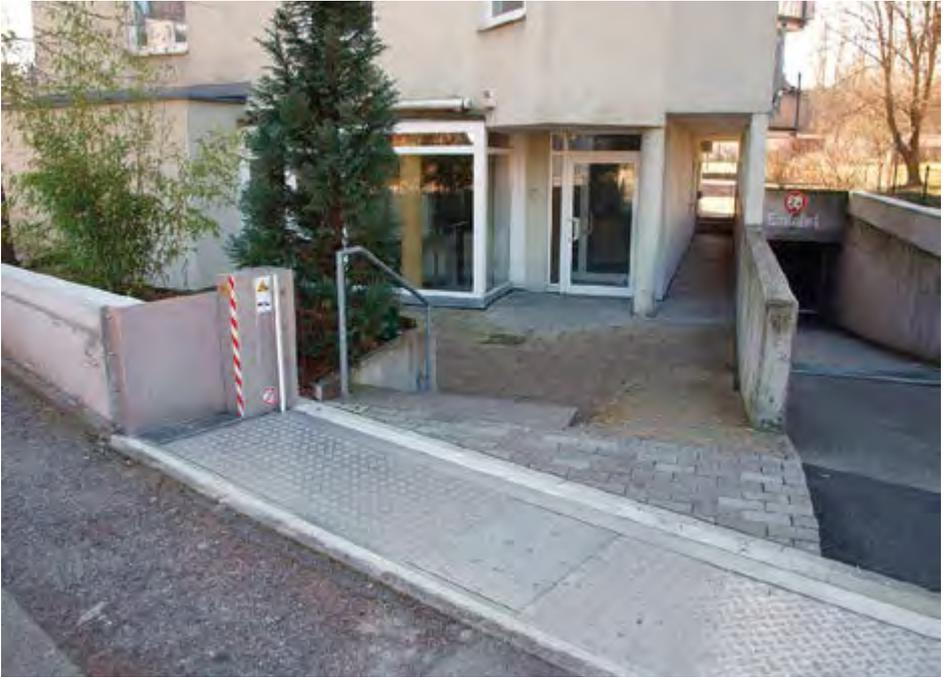
Abb. 95: Automatisches Schutztor einer tiefliegenden Garage und eines Eingangs
