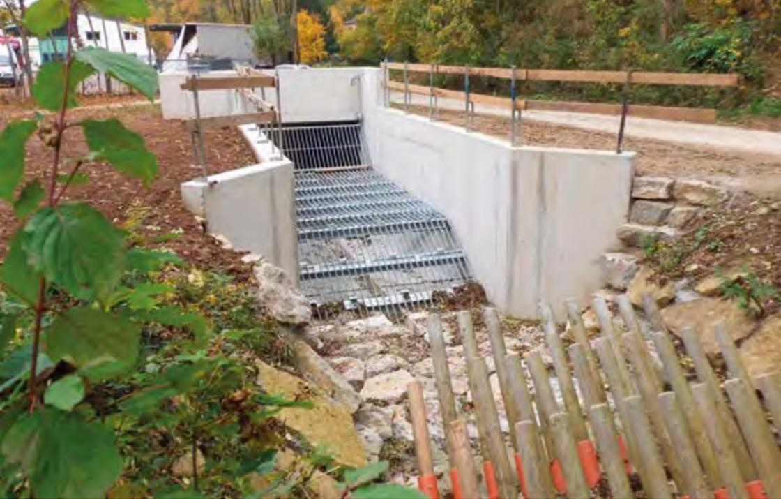
Abb. 78: Neue gebauter Kanalisationseinlauf an einem Bach. Bei Starkregen gilt es, diese Einmündungen immer offen zu halten, damit das Wasser in der Verdohlung bzw. in der Kanalisation abfließen kann.
